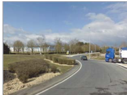
Depuis le Sud, la zone est dissimulée par des boisements. Le rond-Point de Retortat, marque la jonction entre la RD.951 et la RD.373.
