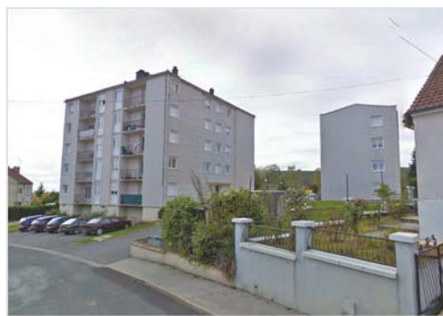
Les Sablons - ensemble de 4 immeubles collectifs
