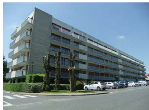
Immeuble avenue Charles de Gaulle
