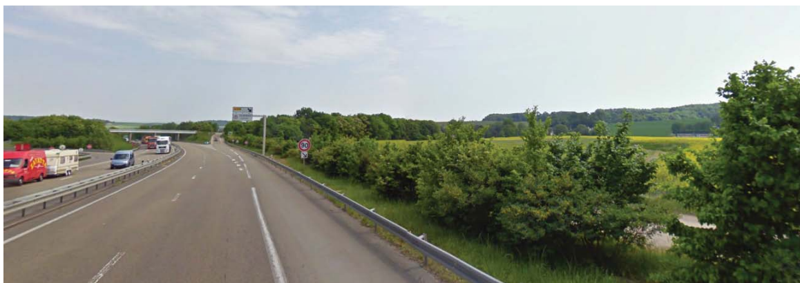
Vue principale (Nord) depuis la RN.4
