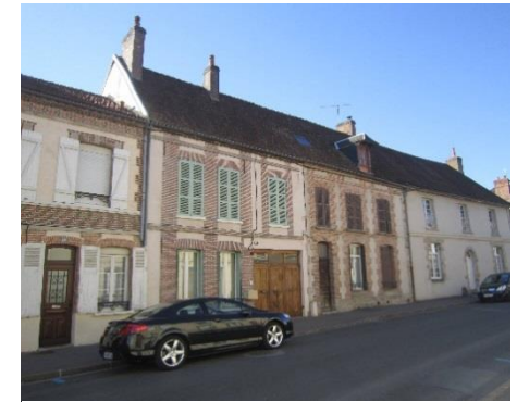
Maison moyenne en maçonnerie enduite et brique de la rue, rue de Paris
