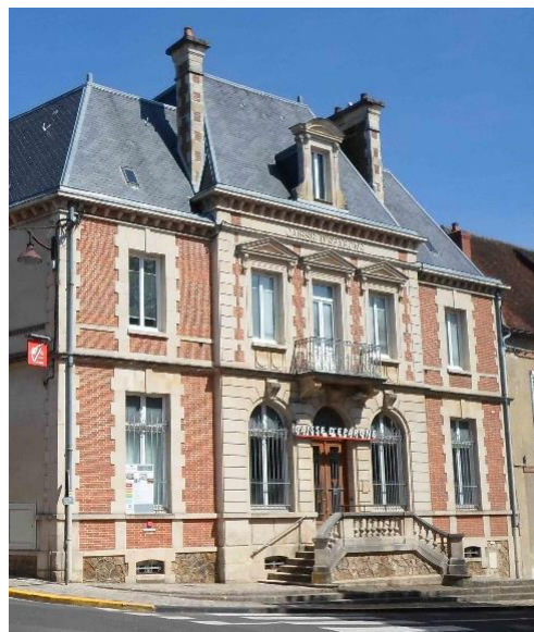
Façade de la Caisse d'Epargne avec des encadrements en pierre et un remplissage en brique rouge – Place du Champ Benoist
