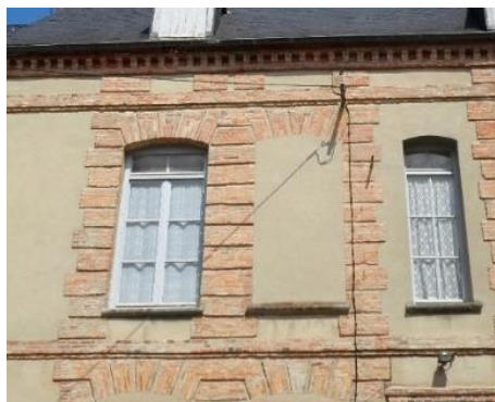
Encadrements de baie harpés à bossage du XVII e siècle- 8, place de l'Hôtel de ville
