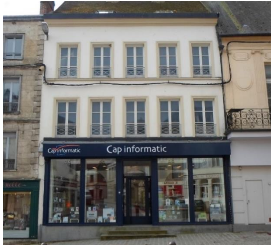
Façade en béton néoclassique, recouverte d'une peinture - 38, Place de la République
