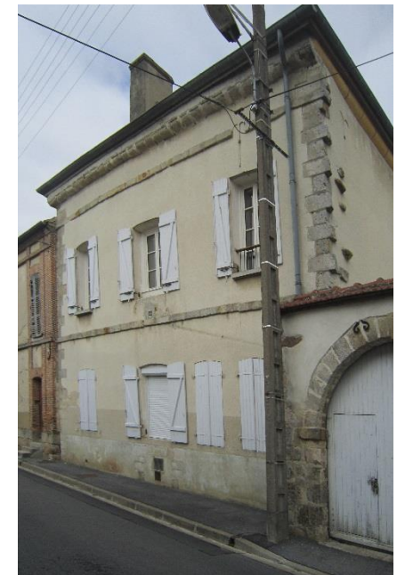
Façade enduite et encadrements de baie en pierre de taille - Bâtiments conventuels de l'ancienne abbaye de Notre-Dame de Bricot, 1633 3, rue Vauvert
