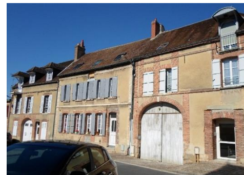
Alignement de maisons moyennes à vocation agricole, rue Pierre Fritte
