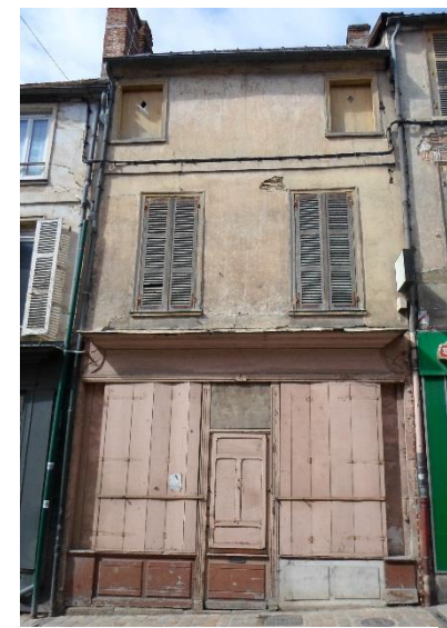
Façade en pan de bois enduit – 3, rue Bouvier Sassot
