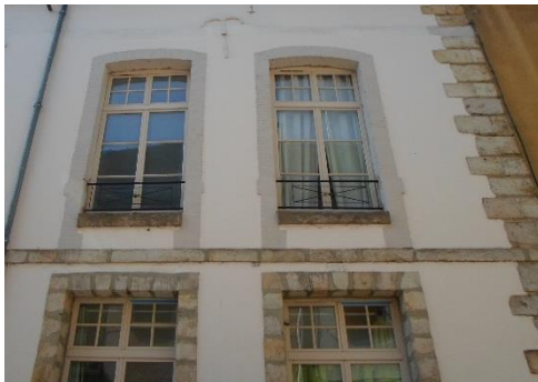
Façades avec encadrements de baie en pierre taille ou mur en maçonnerie rejointoyée, interdisant la possibilité d'une isolation par l'extérieur.
