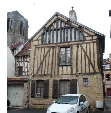
Façades en pan de bois apparent, destiné à être enduit - rue Cognefort
