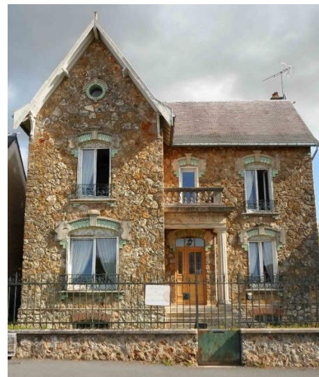
Façade avec des encadrements en pierre et briques vernissées et un remplissage en pierre meulière
