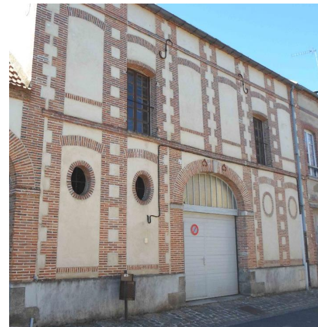
Façade « brique et enduit » du XIXe siècle - 14, rue de l'Hôtel de Ville
