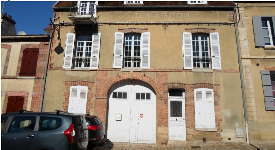
Façade « brique et enduit » avec un encadrement de porte charretière en brique du XVIIIe et des encadrements de baie en brique du XIXe
