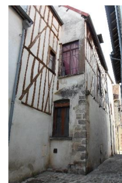
Façades en pan de bois apparent, destiné à être enduit - rue Cognefort
