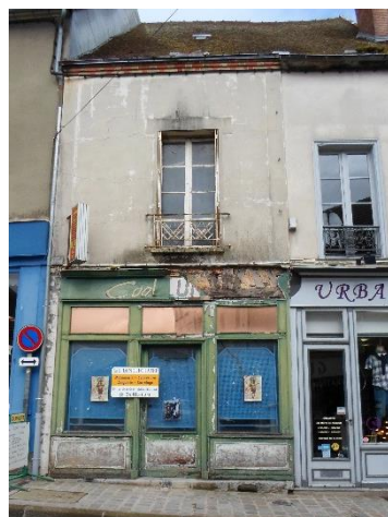
Façade en pan de bois au RDC et corniche en brique ne permettant pas de définir le mode constructif – 18 rue de la Halle
