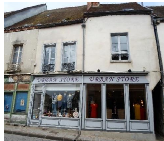
Façades en pan de bois – 20, rue de la Halle (Encorbellement sur la ruelle)
