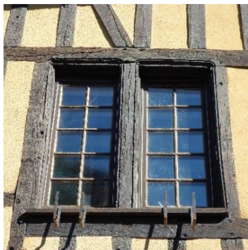
Pan de bois apparent destiné à rester apparent, avec un encadrement de baie mouluré 27, rue d'Épernay
