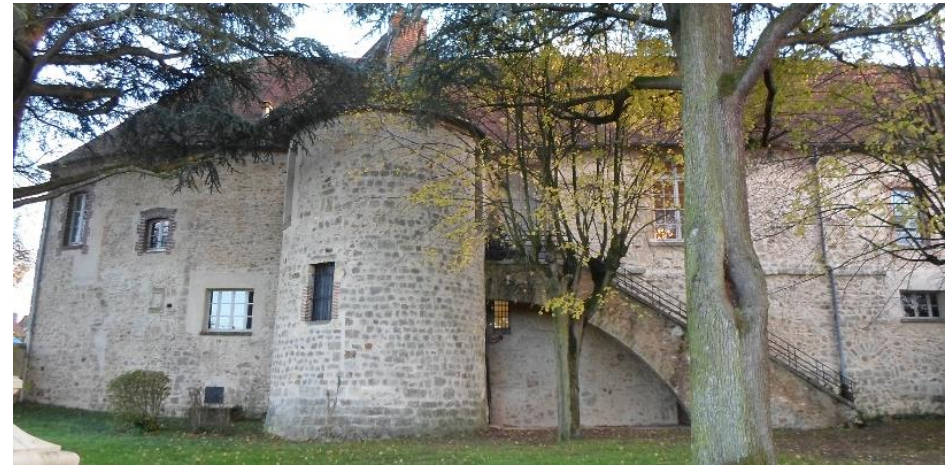
Bâtiment en maçonnerie de moellon de pierre - 20, Cours d'Orléans
