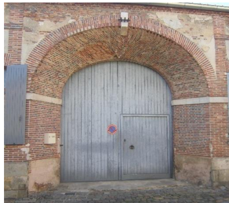
Encadrement de porte en brique
