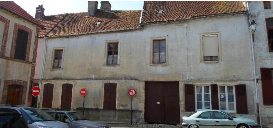
Nécessité de sondages pour définir le mode constructif 23, rue de l'Ancien Hôpital
