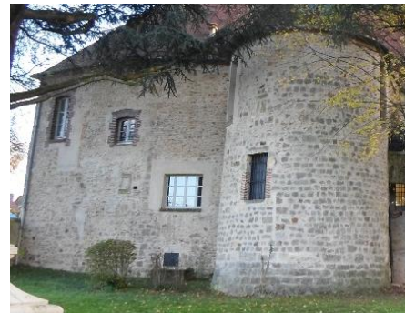
Façades avec encadrements de baie en pierre taille ou mur en maçonnerie rejointoyée, interdisant la possibilité d'une isolation par l'extérieur.
