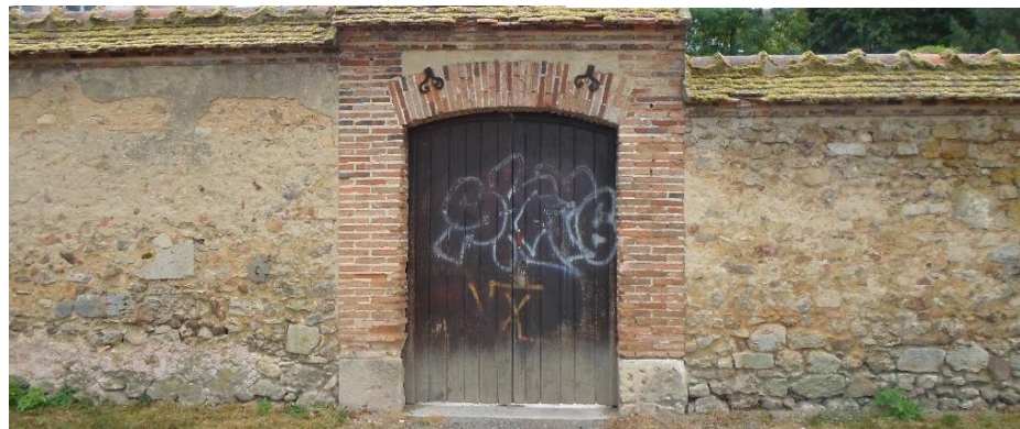
Mur de moellons enduit et encadrement de porte en brique orangée
