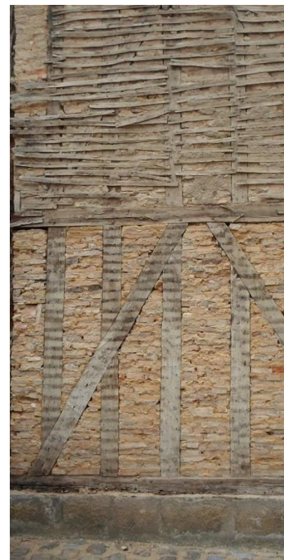
Pan de bois avec un remplissage en moellons et contrelatte en bois d'accrochage de l'enduit
