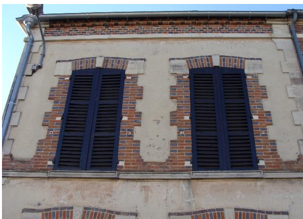
Facade « brique et enduit » avec des briques rouges et des briques vernissées - 56, rue de Broyes
