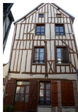
Façades en pan de bois apparent, destiné à être enduit - rue Cognefort
