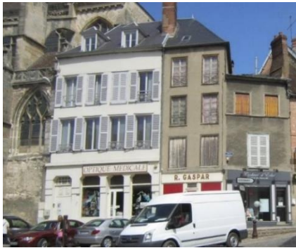
Immeubles de rapport construits sur les fondations de l'église Saint Julien
