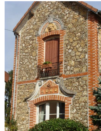
Façade avec des encadrements en brique et des motifs en terre cuite et un remplissage en pierre meulière
