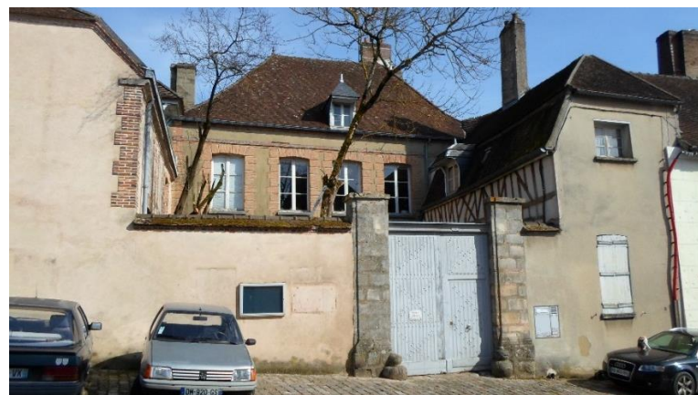
Alignement discontinu 6, rue de la Juiverie. Le mur de clôture, de 3,5m de hauteur, assure la continuité de l'alignement sur l'espace public
