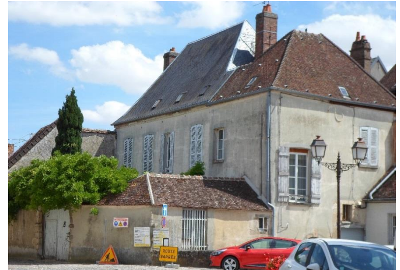
Nécessité de réaliser des sondages pour définir le mode constructif 1, rue des Teinturiers
