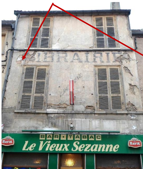
Façade en pan de bois enduit et encadrements de baie moulurés en bois - 5, rue Bouvier Sassot
