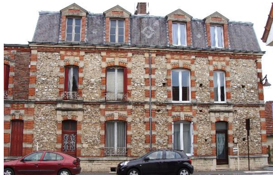
Façade avec des encadrements en brique rouge et vernissée et en pierre de taille et un remplissage en pierre meulière – 108, rue Notre Dame
