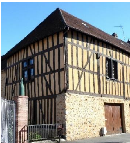
Pan de bois apparent destiné à rester apparent, avec un encadrement de baie mouluré 27, rue d'Épernay
