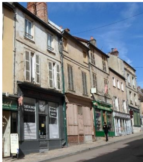
Succession de façades en pan de bois enduit de la rue Bouvier-Sassot
