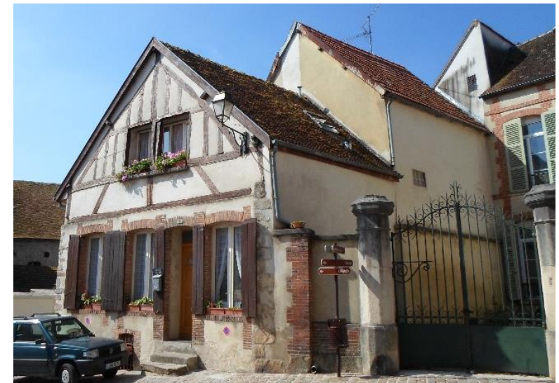
Bâtiment dont les façades sont réalisées selon plusieurs modes constructifs - 3, rue de la Juiverie
