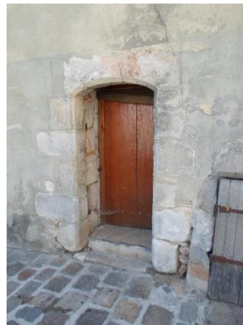
Détail d'un encadrement de baie chanfreiné en pierre de taille (grès) Angle rue de la Halle et rue des Teinturiers
