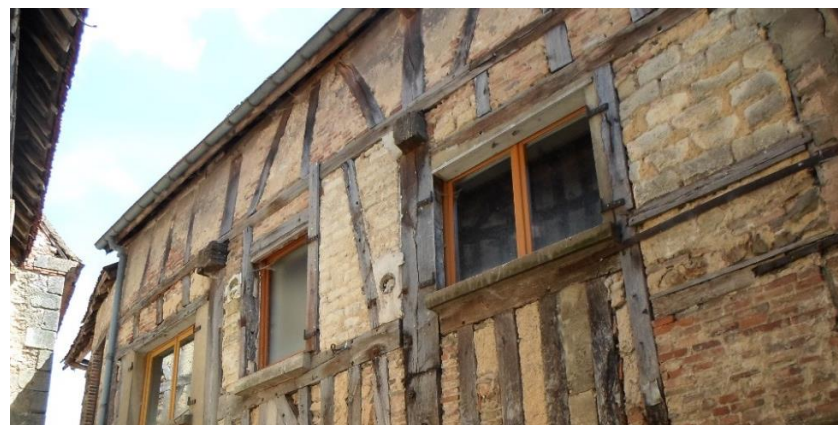
Pan de bois avec remplissage en brique ou en carreaux de terre
