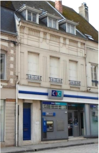
Façade en béton du début du XXe – 64, place de la République
