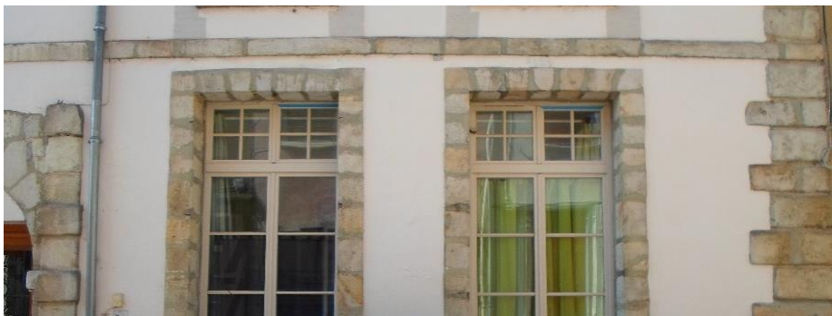
Façade enduite et encadrements de baie en pierre de taille - 21, rue de l'Ancien Hôpital
