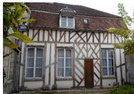
Commun d'hôtel particulier en pan de bois et remplissage enduit – 6, rue de la juiverie
