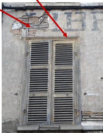
Façade en pan de bois enduit et encadrements de baie moulurés en bois - 5, rue Bouvier Sassot
