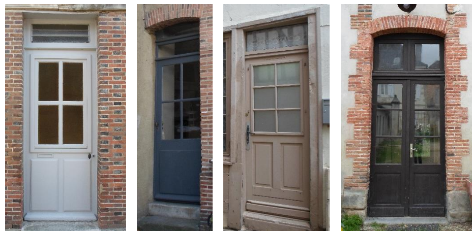
(2) Exemples de portes à panneaux, la partie supérieure largement vitrée avec des petits bois
