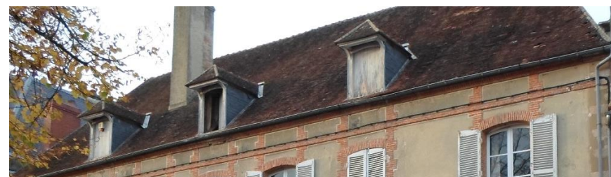
Ensemble de 3 lucarnes à capucine avec une croupe débordante, couverture en petites tuiles plates, encadrements en bois et joues en ardoise.
