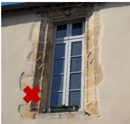
Enduits saillants, dénaturant les encadrements de baie chanfreinés de style renaissance
