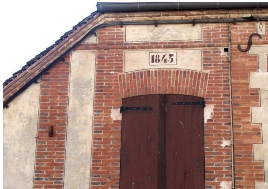
Enduit à la chaux, finition lissée au nu des encadrements, rehaussé par un liseré noir
