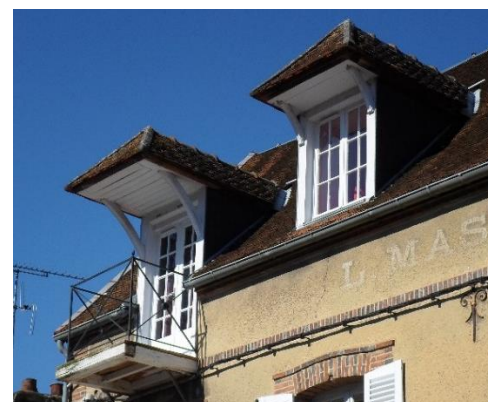
Lucarne engagée ou passante - Lucarne à capucine, avec croupe débordante et encadrement en bois
