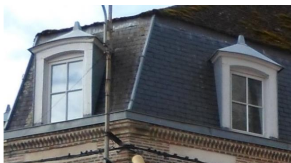
Lucarne à la Mansart, encadrement en bois et couverture en zinc
