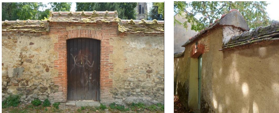
Photo 5 et 6 : Un couronnement de mur de clôture réalisé en petites tuiles plates dont le faîtage est recouvert d'une tuile semi-circulaire, avec crêtes et embarrures en mortier de chaux ou tuiles semi-circulaires à bourrelet de recouvrement
