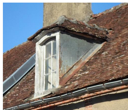
Lucarne capucine à croupe à l'aplomb de la façade, encadrement en bois et linteau cintré
