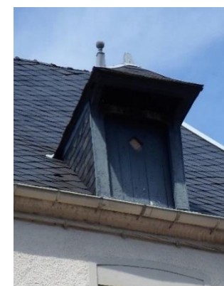
Lucarne engagée ou passante - Lucarne à capucine, avec croupe débordante et encadrement en bois
