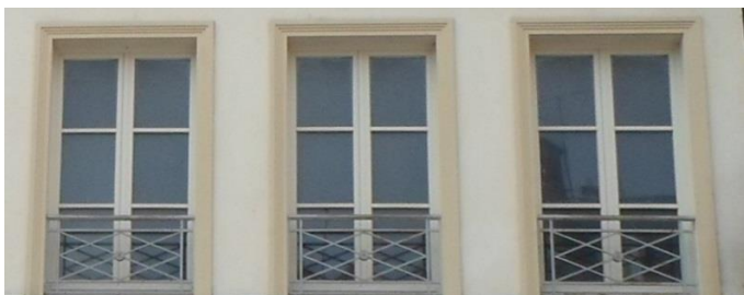
Exemple de garde-corps s'inspirant des ferronneries anciennes
