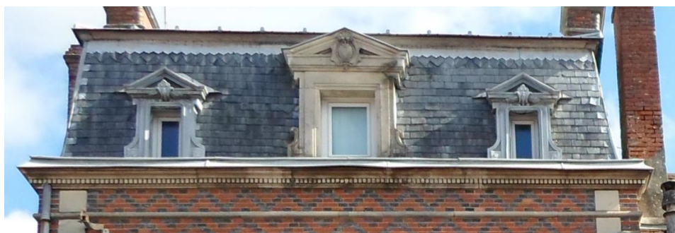
Lucarne à fronton en pierre et en zinc de style éclectique de la fin du XIXe siècle
