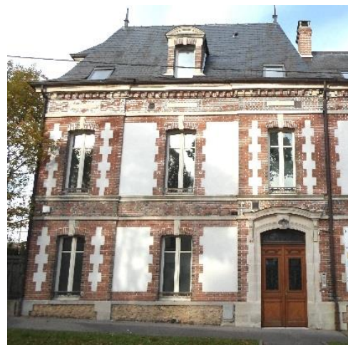
Façade avec encadrements en brique et en pierre de taille, remplissage en duit et soubassement en meulière - 137, route de Paris
