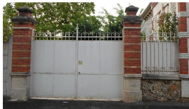
Photo 13 : portail et clôture métalliques
