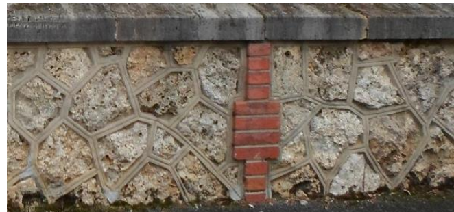
Mur en pierre meulière avec joint en ciment saillant en « opus incertum » Rue Aristide Briand
