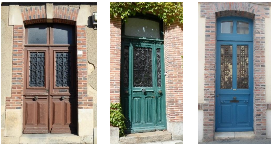
(3) Exemples de portes composées de panneaux moulurés et assemblés, la partie supérieure vitrée et protégée par des grilles de défense en fer forgé ou en fonte moulée
