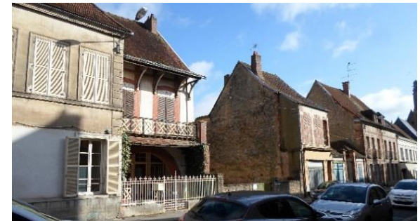
Exemple de rupture d'alignement et de perte de la continuité du bâti, générant des pignons aveugles.
