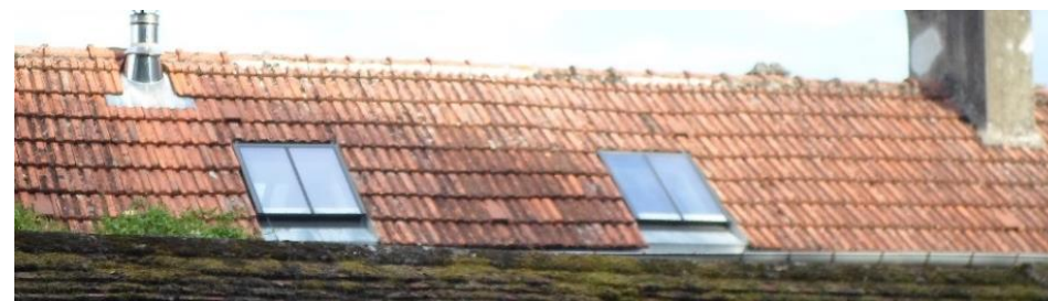
Exemple de châssis de toit métallique de type patrimoine avec un meneau central assimilé aux anciennes tabatières et verrière de toit (rue de Vauvert)
