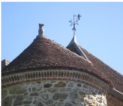
Épis de faîtage figuratif en terre cuite et métallique avec girouette
