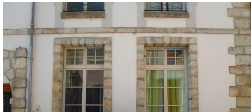
Enduit taloché avec les encadrements de baie en pierre de taille légèrement saillant
