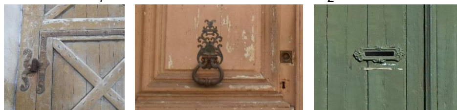
Exemples de serrureries et ferronneries : ancrés de linteau en demi cintre (1), pentures de volet (2) et de porte (3), heurtoir de porte (4) et fente de boîte aux lettres (5)
