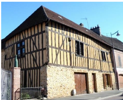
Pans de bois destinés à rester apparents, avec un encadrement de baie mouluré - 27, rue d'Épernay
