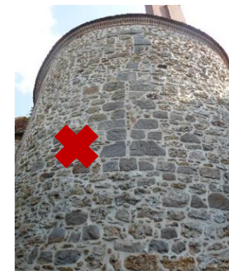
Mur en maçonnerie rejointoyé avec des joints au ciment. Ce mur, constitué de moellons grossièrement équarris et non assisés, devrait être revêtu par un enduit taloché ou un enduit « à pierre vue »
