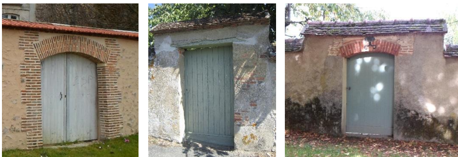
Exemples de portes en bois constituées de planches verticales utilisées pour les portes d'entrée de jardin
