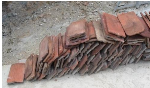
Dimension courante des petites tuiles plates et petites tuiles plates de récupération
