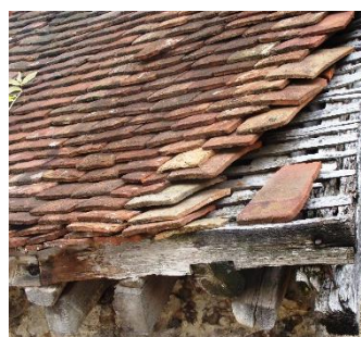
Mise en œuvre de la petite tuile plate sur chevron et lattis
