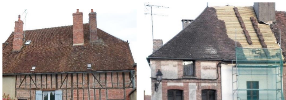
Couverture en petites tuiles plates et réfection d'une couverture en cours
