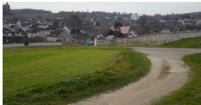
Sinuosité des chemins en terre argilo-calcaire stabilisée
