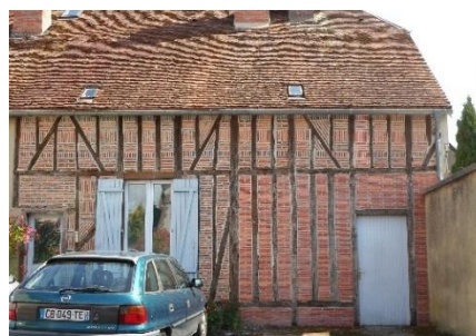
Pans de bois destinés à rester apparents, avec un encadrement de baie mouluré - 27, rue d'Épernay
