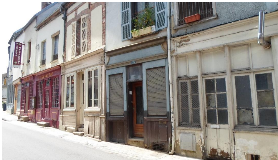
Photo 5 : Ensemble de devantures en applique avec panneaux formant allège, bandeau en partie haute formant coffre et support de la raison sociale. Ce dernier est surmonté d'une corniche légèrement saillante.
