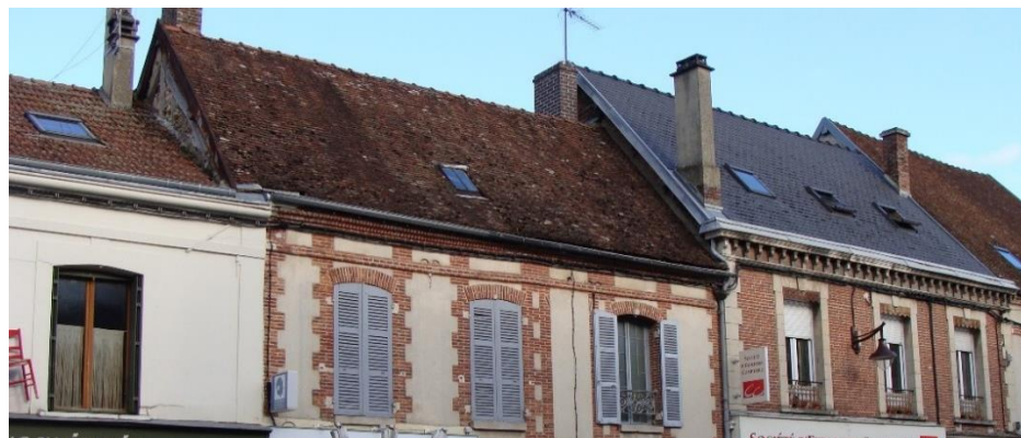
Couverture en petites tuiles plates et couverture en ardoises sur un immeuble du XIXe siècle
