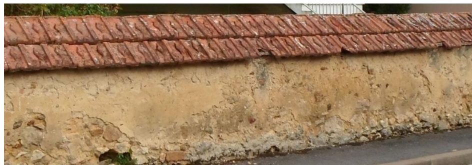
Photo 2 : mur recouvert d'un enduit à la chaux taloché
