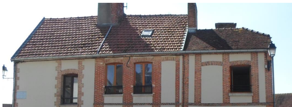
Tuiles mécaniques « à côte » sur bâtiments, place de la Halle - densité 13 au m 2
