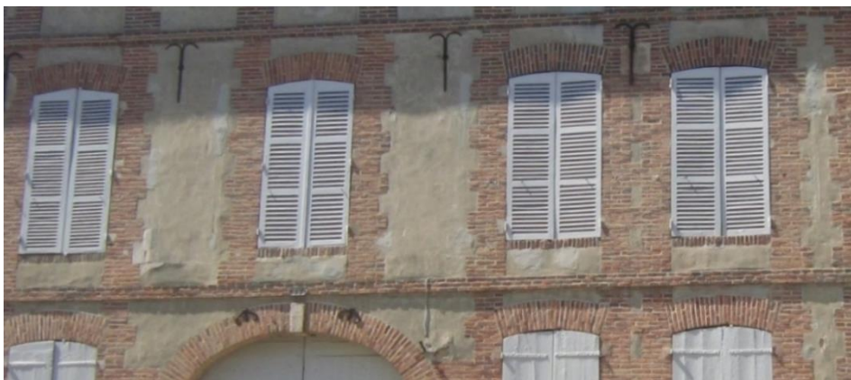
Enduit à la chaux, finition lissée au nu des encadrements
