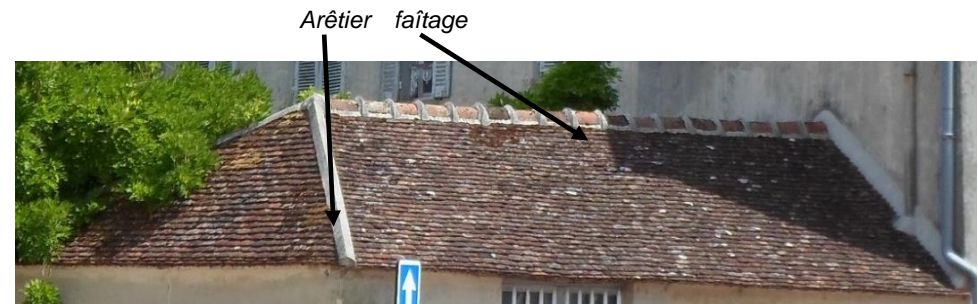
Couverture en petites tuiles plates. Le faitage est réalisé en tuile semi-circulaire avec crêtes et embarrures en mortier de chaux. L'arêtier de la croupe est constitué d'un solin en mortier de chaux.
