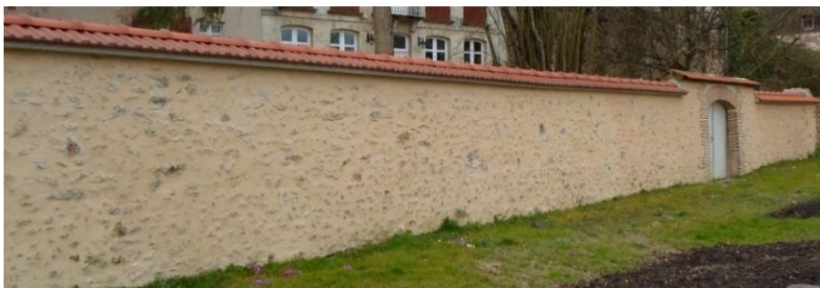
Photo 1: mur recouvert d'un enduit à pierre vue
