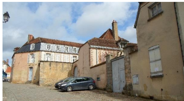
Exemple de mur de clôture assurant la continuité de l'alignement sur la rue
