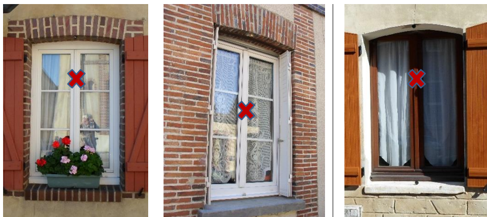
(1) Exemple interdits : (1) fenêtrés PVC type rénovation sur bâti bois existant (2) fenêtrés en PVC avec petits bois à l'intérieur du vitrage (3) fenêtrés en bois lasuré et sans petits bois
