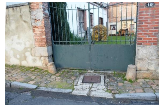
Trottoir en pavés de grès et chasse-roues en pierre
