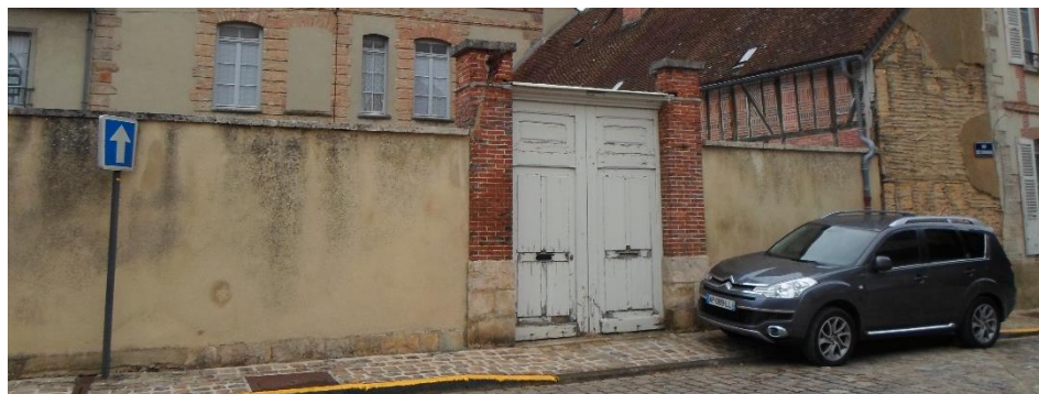
Photo 4 : Un couronnement de mur de clôture réalisé en dalles de pierre de taille
