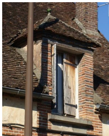
Lucarne capucine passante ou engagée avec encadrement en brique, axée sur une baie
