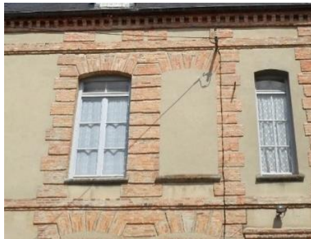
Encadrements de baie harpés à bossage du XVII e - 8, place de l'Hôtel de ville
