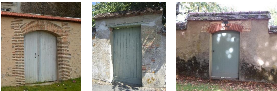
(1) Exemples de portes en bois, constituées de planches verticales, utilisées pour les portes d'entrée de jardin
