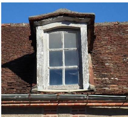
Lucarne capucine à croupe à l'aplomb de la façade, encadrement en bois et linteau cintré
