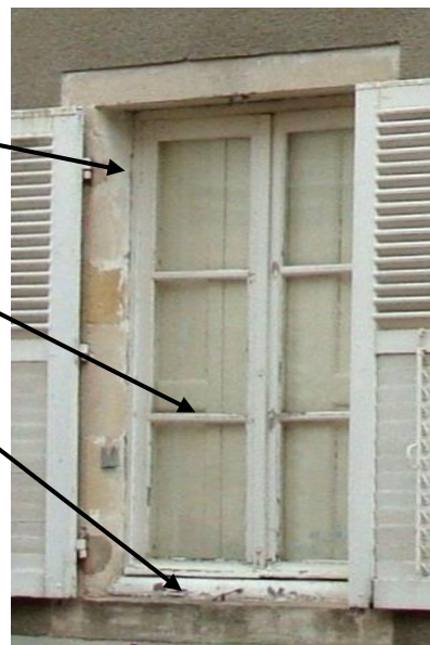
Exemple de fenêtre en bois peint à grands carreaux
