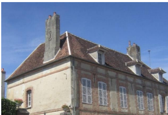
Souche de cheminée en maçonnerie enduite et souche de cheminée en brique
