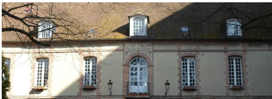
Lucarnes capucines à linteau courbe, axées sur les baies de la façade
