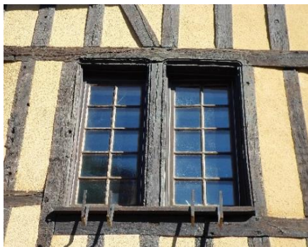
Pans de bois destinés à rester apparents, avec un encadrement de baie mouluré - 27, rue d'Épernay
