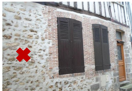
Mur en maçonnerie rejointoyé avec des joints au ciment. Ce mur, constitué de moellons grossièrement équarris et non assisés, devrait être revêtu par un enduit taloché ou un enduit « à pierre vue »
