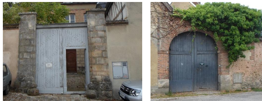
Photo 9 et 10 : portes en planches jointives verticales
