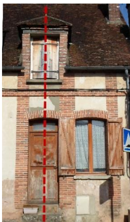
Lucarne capucine passante ou engagée avec encadrement en brique, axée sur une baie
