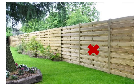
Photo 8 – Exemple de clôture interdite en panneaux bois
