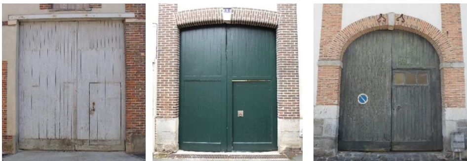
Exemples de portes charretières, composées de planches verticales.
