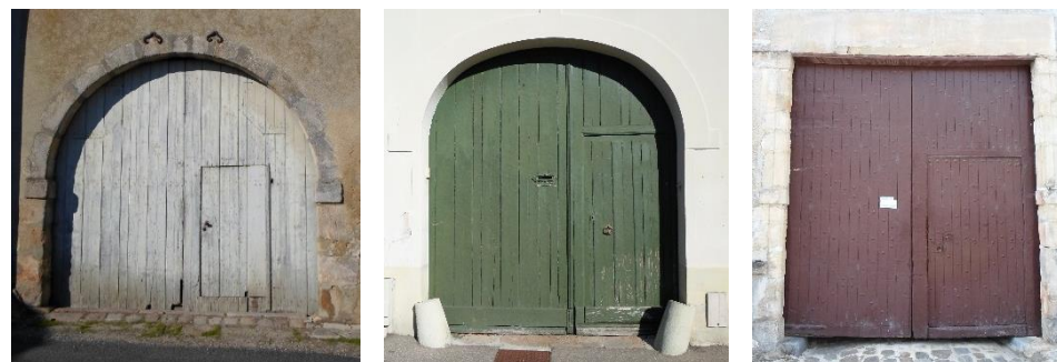
(1) Exemples de portes charretières composées de planches verticales
