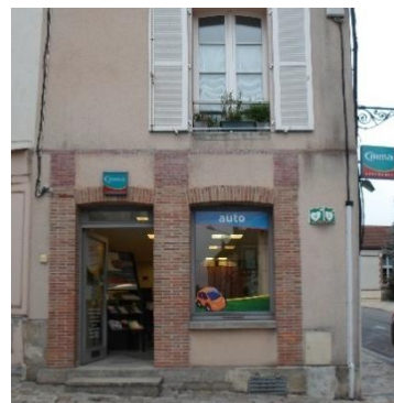
Photo 1 : Devanture commerciale en feuillure
