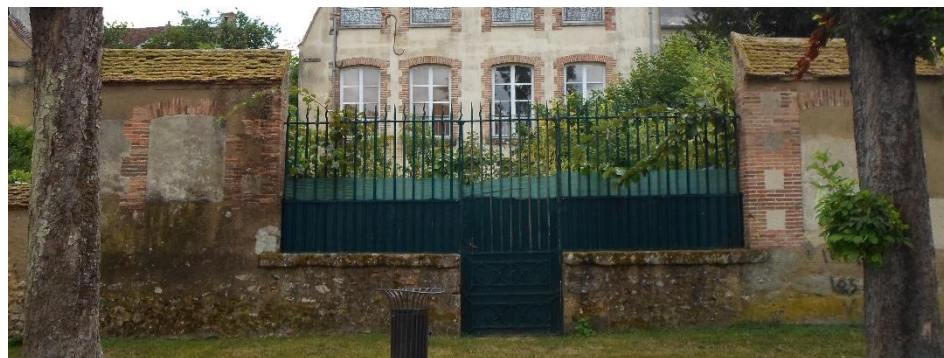
Photo 3 : mur bahut surmonté d'une grille en ferronnerie
