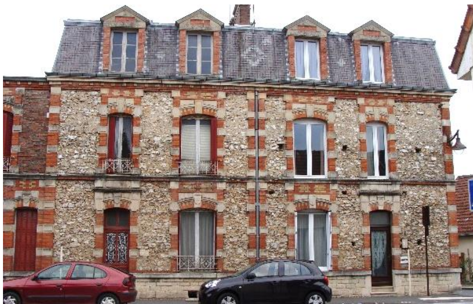
Façade en briques rouges et vernissées, pierre de taille, meulière et enduit - 102, rue Notre Dame
